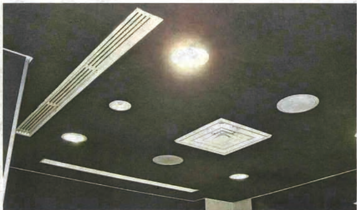
アーテック工房の「ヘルスコート」を塗布した天井
